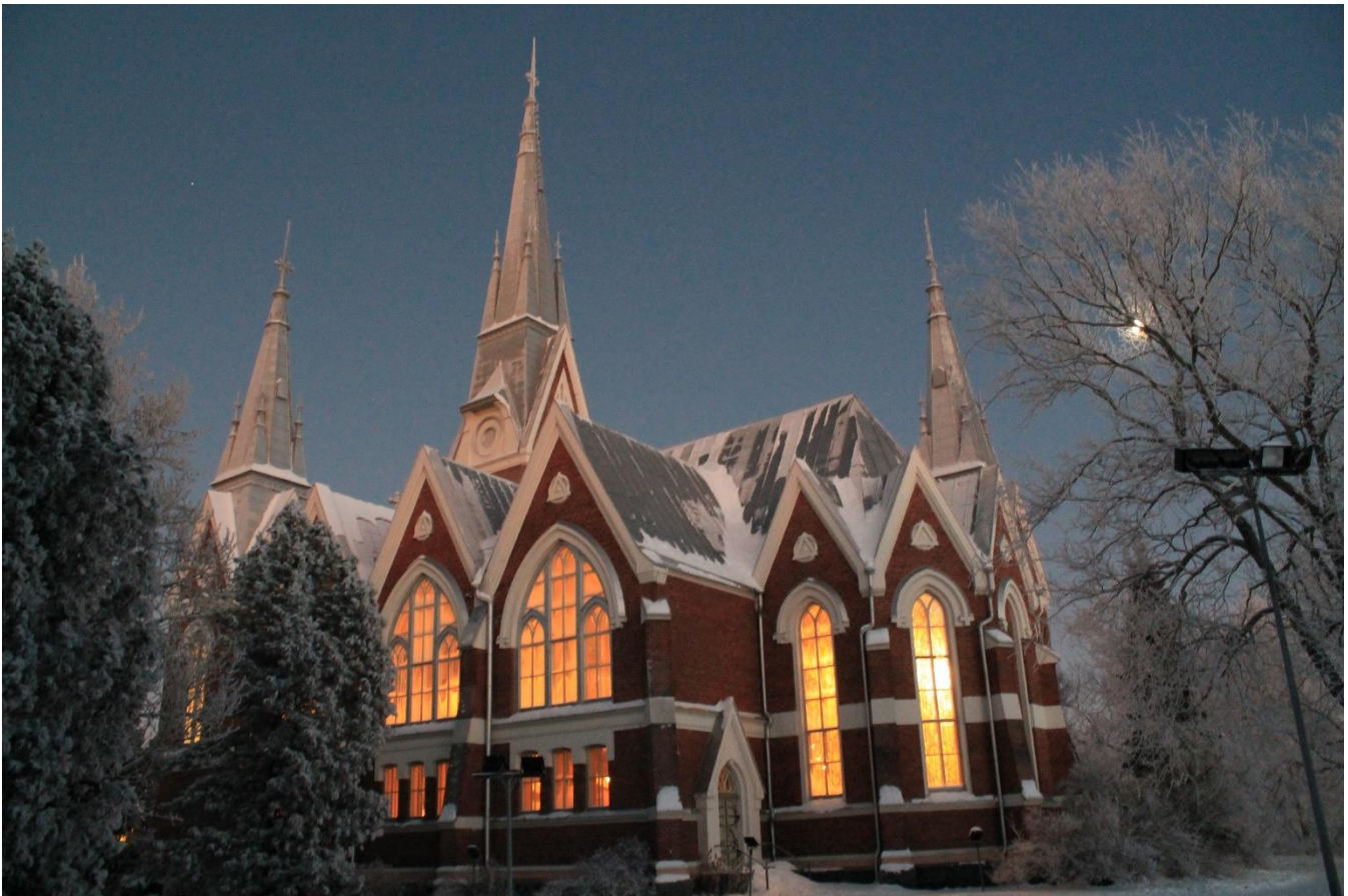
Abbildung 1: Blick auf die evangelische Kirche von Südwesten am 23.12.2012 © RLA.
